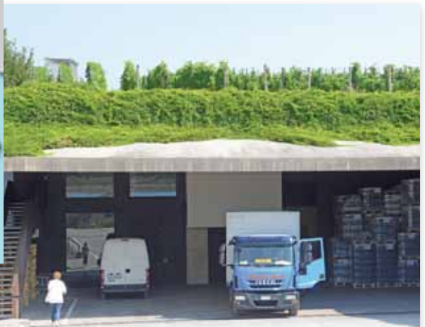
SOUS LA VIGNE, LE CHAI écologique de Manincor. Creusé en profondeur, il conserve la fraîcheur et consomme peu de chauffage et de climatisation.
